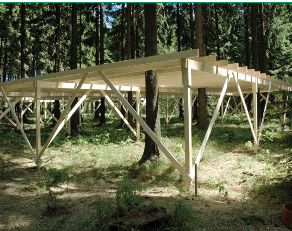
Im Rahmen der DFG-Forschergruppe „Dynamik von Bodenprozessen bei extremen meteorologischen Randbedingungen“ neu errichtete Dachkonstruktion
