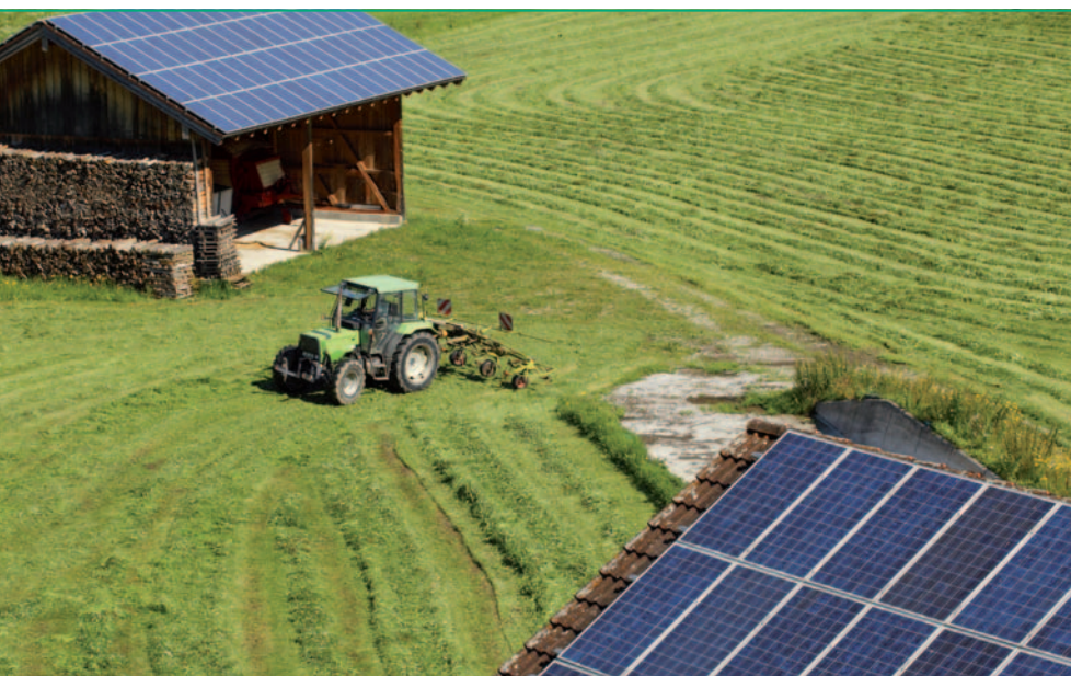
Abb. 2: Photovoltaik-Anlage im ländlichen Raum (sst).
