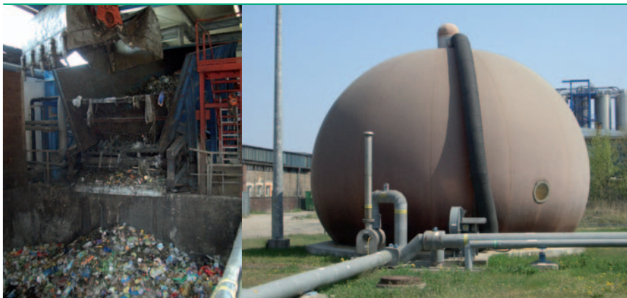
Abb. 3: Biogasanlage der Firma Biokraftwerke Fürstenwalde GmbH (Fotos: Dr. A. Weiss).
