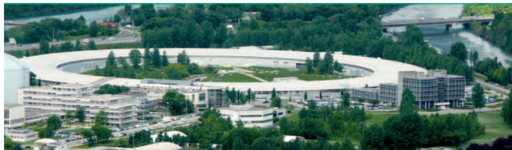
Abb. 7: Das Gebäude der Europäischen Synchrotronstrahlungsquelle ESRF in Grenoble (Foto: Bernd Gross).
