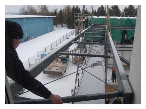
Passt: Die Stahlkonstruktion, die künftig die Zentrale Universitätsverwaltung mit der Aufstockung des Dezernats Z/I verbindet, ist installiert.
