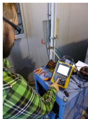
Prozess- und Energieverbrauchs- aufnahme bei einem Anwender- unternehmen
