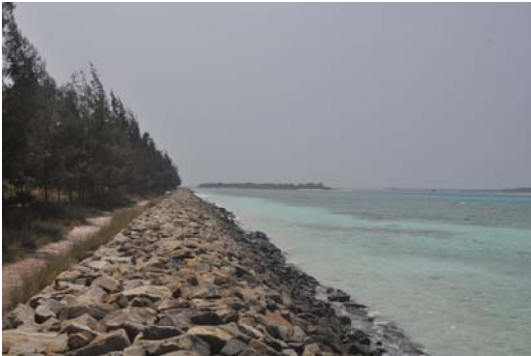
Lange Küstenabschnitte der dauerhaft besiedelten Malediven-Inseln werden durch Befestigungen vor Erosion geschützt, was den Lebensraum für küstenbewohnende Arten stark einschränkt. Foto: Sebastian Steibl.
