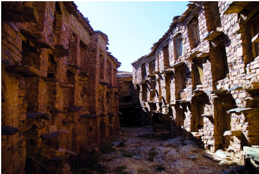
Der Agadir Imhaïlen: Links und rechts befinden sich auf drei Stockwerken die Eingänge zu den Speicherkammern.
